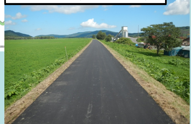
堤防天端の保護 (中渚滑右岸地区)
