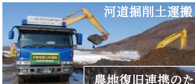
河道掘削（福山左岸地区）
