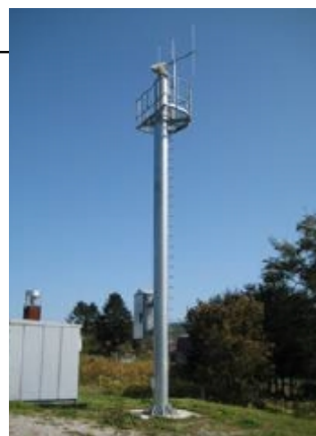
CCTVカメラの設置
