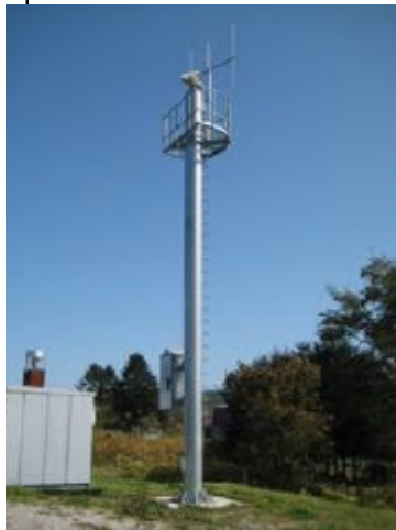
CCTVカメラの設置
