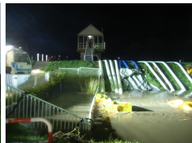
排水ポンプ車による排水 H27.10月 美幌町
