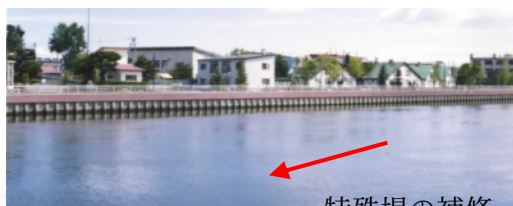
特殊堤の補修
