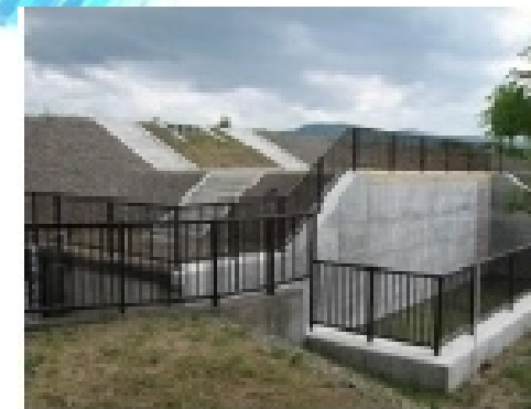
釜場の設置例
