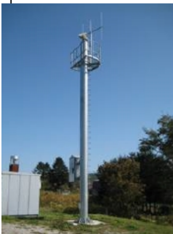
CCTVカメラの設置
