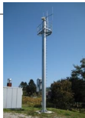
CCTVカメラの設置
