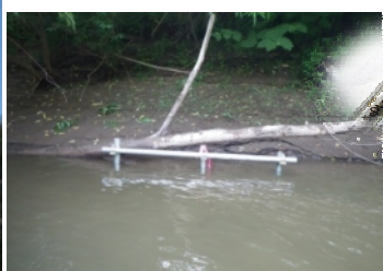
簡易水位計などの設置
