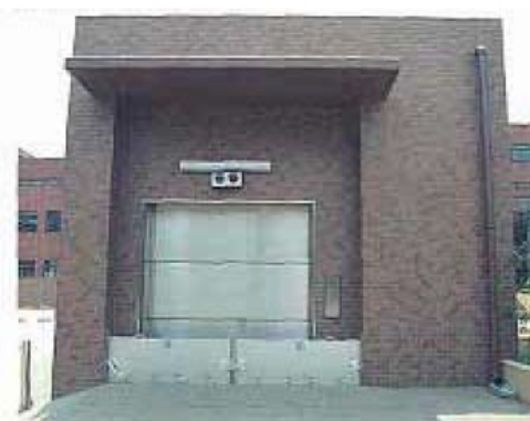
遮水設備による浸水の防止（イメージ）
