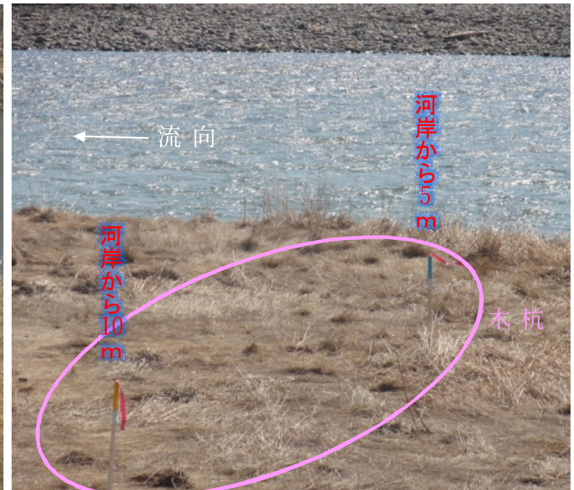
河岸侵食状況把握のための木杭設置状況 (KP11.8)
