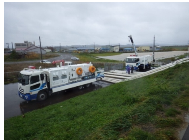
湧別川河口樋門釜場
