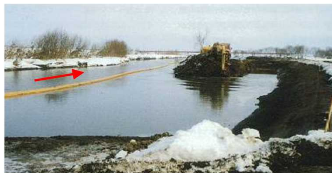
② 下流域の河道掘削 (昭和62年～平成5年整備)
