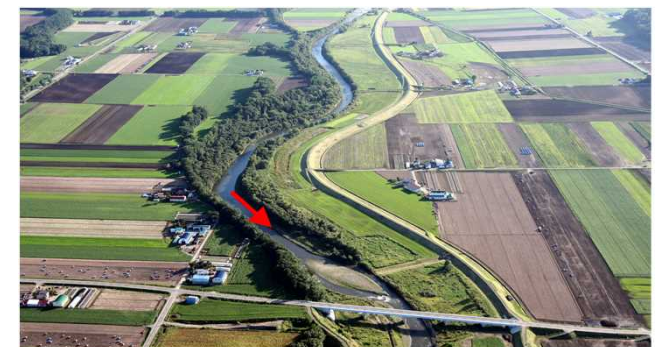
③ 中流域の堤防整備 (昭和54年～昭和55年整備)
