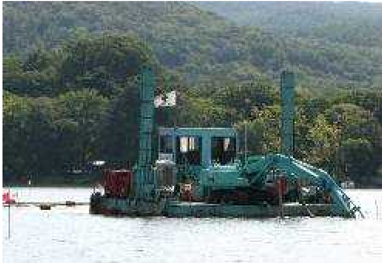
網走湖の浚渫状況
