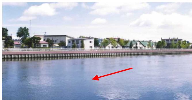
① 網走湖下流域の特殊堤整備 (中央橋上流右岸)
