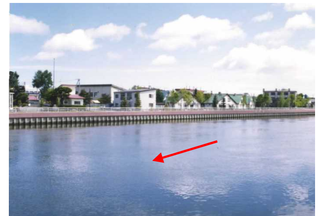
特殊堤を設置した街並み
