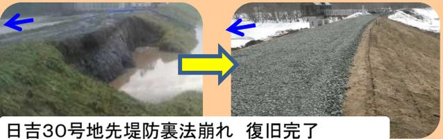
日吉30号地先堤防裏法崩れ 復旧完了
