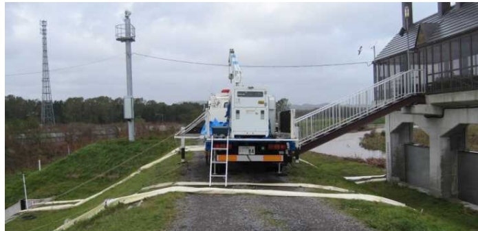
渚滑右岸樋門 排水作業状況 (平成18年10月)
