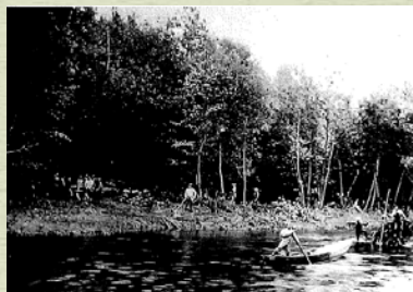
流送のため障害物除去作業 (明治の末、美幌町昭野付近)
