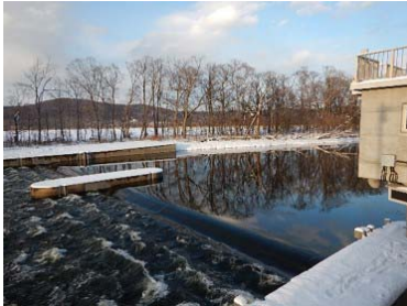
網走川大曲堰による海水の流入抑制状況
