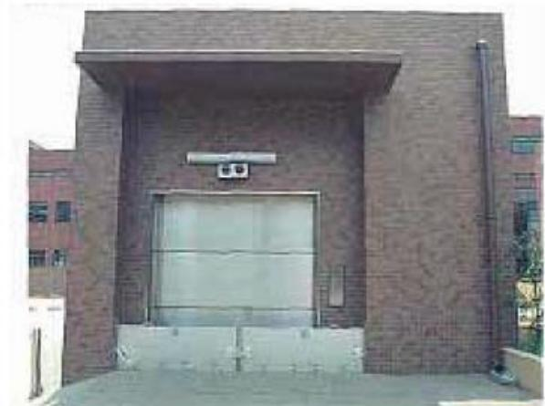
遮水設備による浸水の防止（イメージ）
