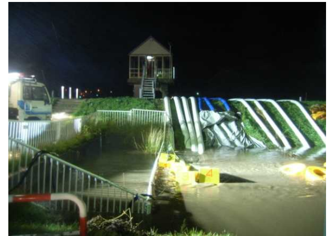
排水ポンプ車による排水 H27.10月 美幌町
