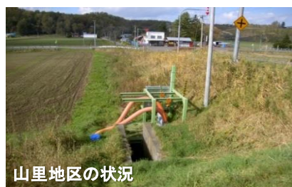
釜場に常設電源、ポンプ設置
