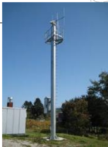
CCTVカメラの設置
