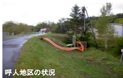
釜場に常設電源、ポンプ設置
