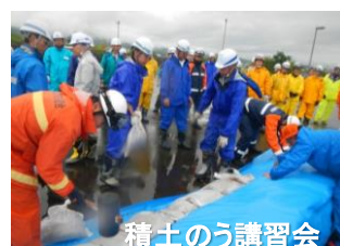
水防工法実施訓練(釜段工法)
