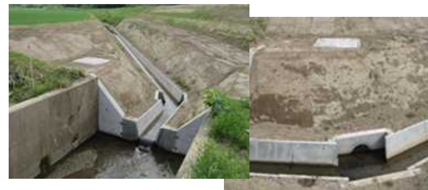
排水ピットの設置
