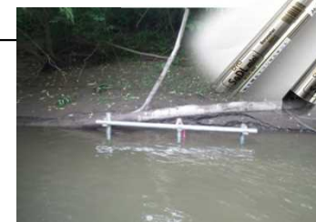
簡易水位計などの設置
