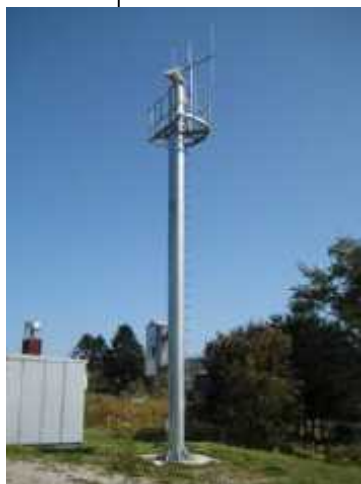
CCTVカメラの設置
