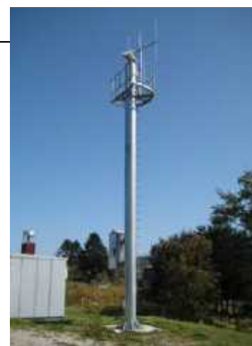
CCTVカメラの設置
