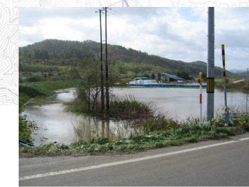
平成10年10月洪水の状況 (ウツツ地区の内水氾濫状況)
