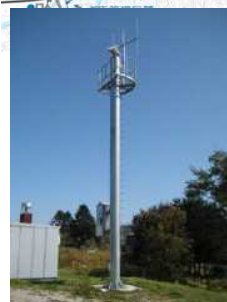
CCTVカメラの設置
