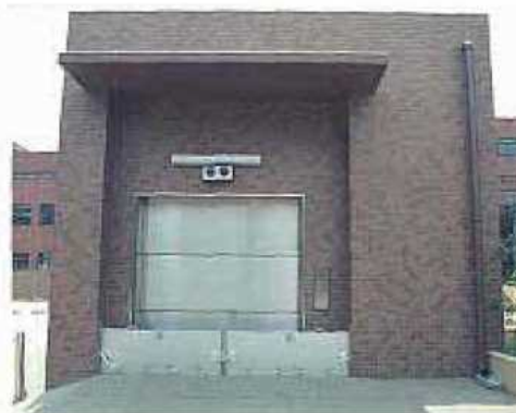
遮水設備による浸水の防止（イメージ）
