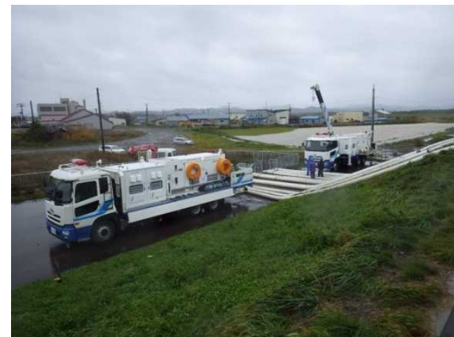
湧別川河口樋門釜場
