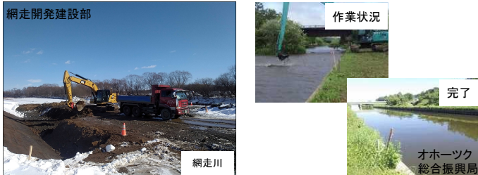
河道掘削実施状況
