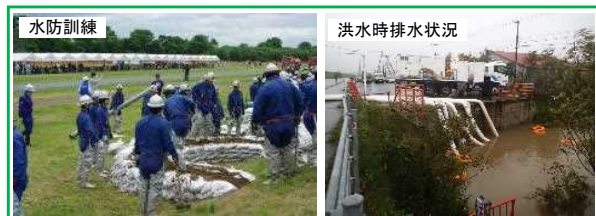
洪水を想定した排水計画作成と訓練 （網走開発建設部、オホーツク総合振興局、網走市、大空町、美幌町、津別町）
