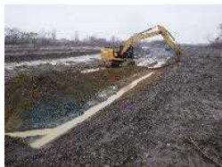
河道掘削 (石狩川水系、北海道開発局)
