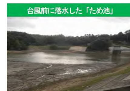
(H26.10 淡路市志筑 黒田池)
