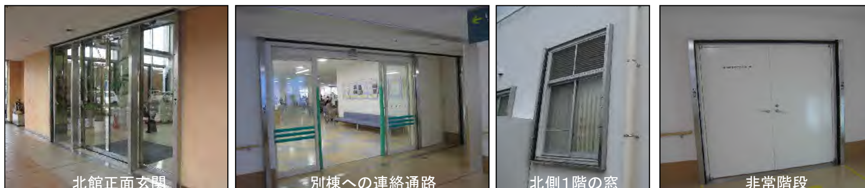
止水板のための角落し設置
