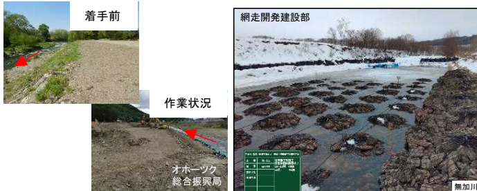
河道掘削状況
