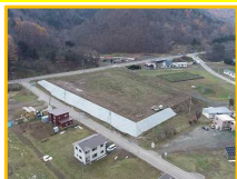
嵩上げ盛土による浸水対策を講じた複合型公共施設を整備(北見市)
