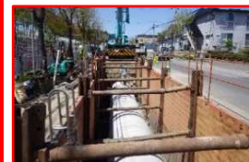
下水道雨水管の整備 (北見市)
