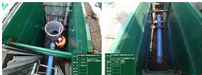
下水道雨水管の整備状況
