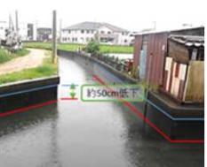
用水路の事前水位低下による雨水貯留
