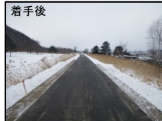
天端保護実施状況 無加川(道管理区間)
