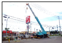
下水道雨水管の整備状況
