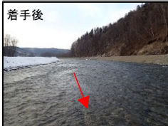
河道掘削実施状況 無加川(道管理区間)
