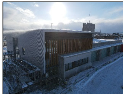
消防庁舎の工事実施状況
