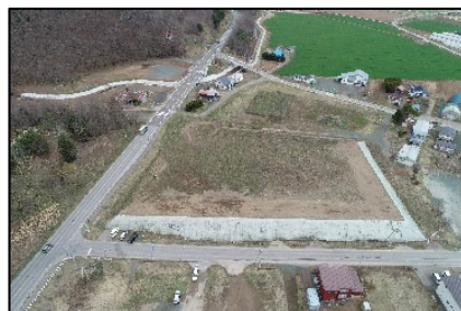
浸水対策を講じた複合型公共施設の盛土造成状況
