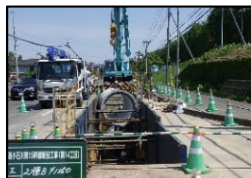
下水道雨水管の整備状況
