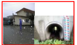
下水道雨水管の整備（遠軽町）
