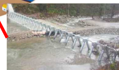
流木捕捉施設の設置
