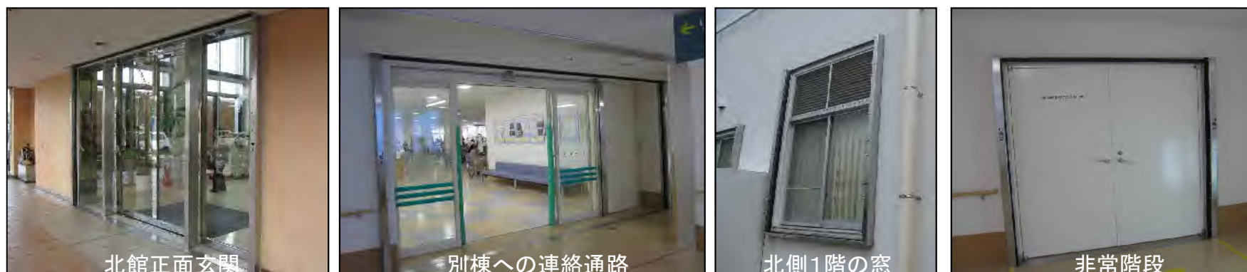
止水板のための角落し設置
