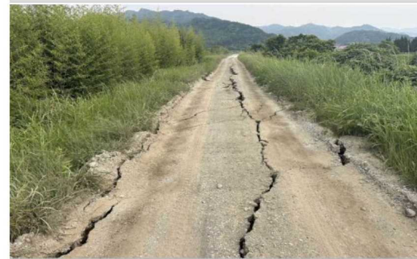
ひろとがわ ひろとがわ 広渡川水系広渡川の堤防天端の亀裂 にちなんし (宮崎県日南市)
