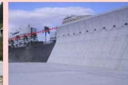
海岸保全施設整備
