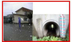
下水道雨水管の整備(遠軽町)
