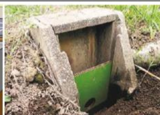
田んぼダム（調整板設置）
