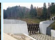
砂防関係施設整備
