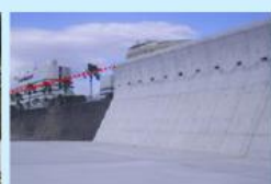
海岸保全施設整備
