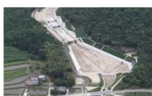
土砂や流木を効果的に捕捉する遊砂地等の設置
