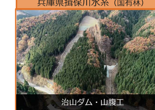
治山ダム・山腹工
