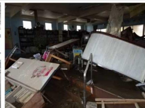
令和2年7月豪雨の被害
