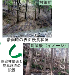
豪雨時の表面侵食状況 対策後（イメージ） 保安林整備と簡易施設設置 雨水の浸透促進・地表流の流速低減
