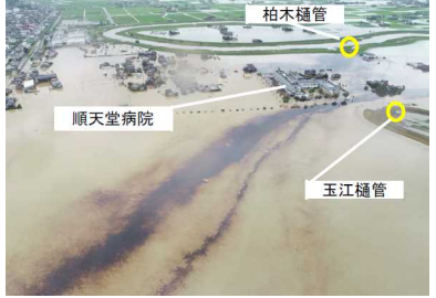
⑧六角川周辺における浸水被害状況 (佐賀県大町町)
