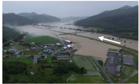
③常呂川の氾濫による浸水被害 (北海道北見市)
