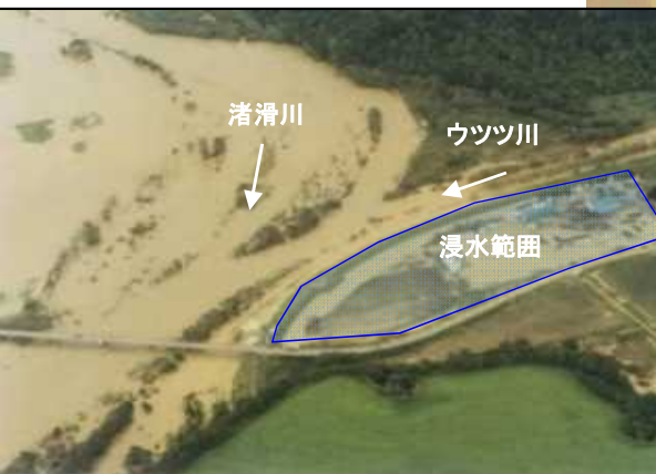
平成10年9月台風 被害家屋197戸、氾濫面積310ha
