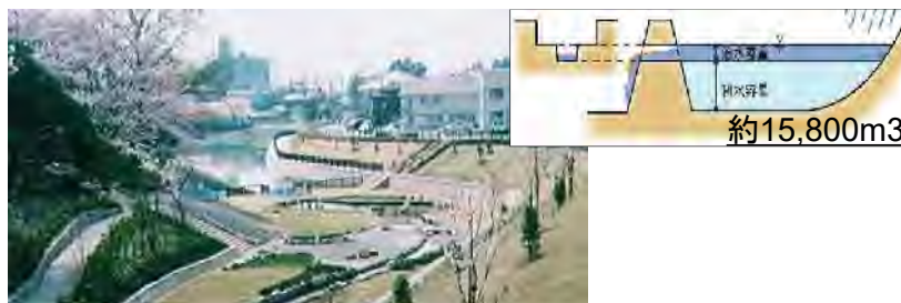
(事例)ため池を改良した流域貯留施設
