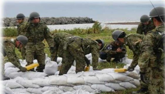
水防工法訓練（月ノ輪工法）
