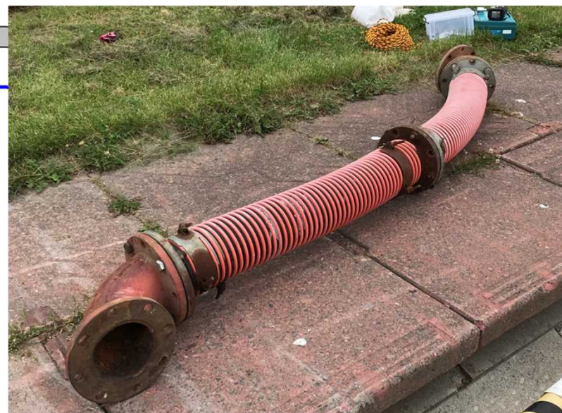
導水管の延伸
