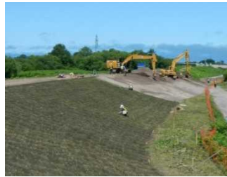
湧別川の浸透対策状況 (堤防断面拡大工法)
