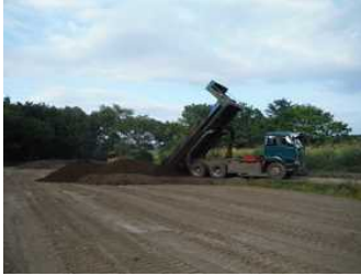
農地復旧状況
