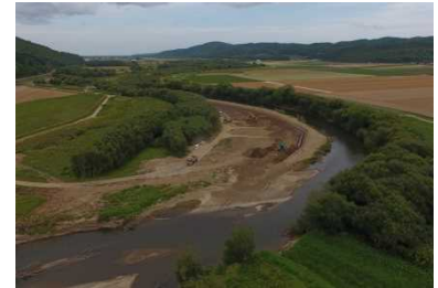
常呂川の河道掘削状況
