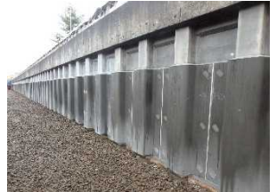
網走川特殊堤の補修完了状況
