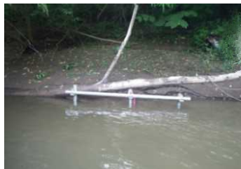
簡易水位計などの設置
