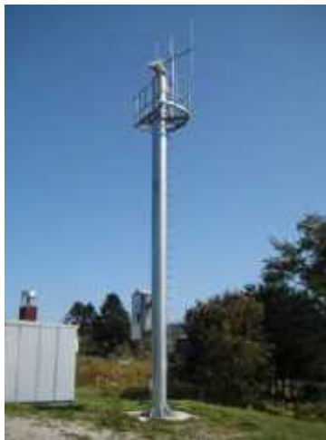
CCTVカメラの設置
