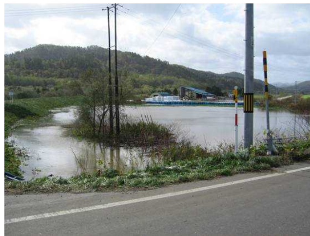
平成10年10月洪水の状況 (ウツツ地区の内水氾濫状況)
