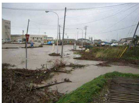
平成18年10月洪水の状況 (湧別町 河口漁港の被災状況)
