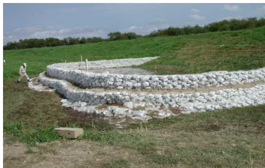
平成13年9月 漏水対策工 (大空町:網走湖住吉・本郷地区)
