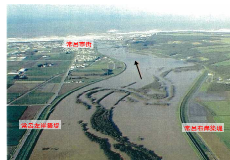
平成10年9月洪水の流下状況 (北見市)
