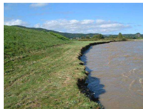
平成13年9月洪水の状況 (高水敷の侵食の状況) 遠軽町内
