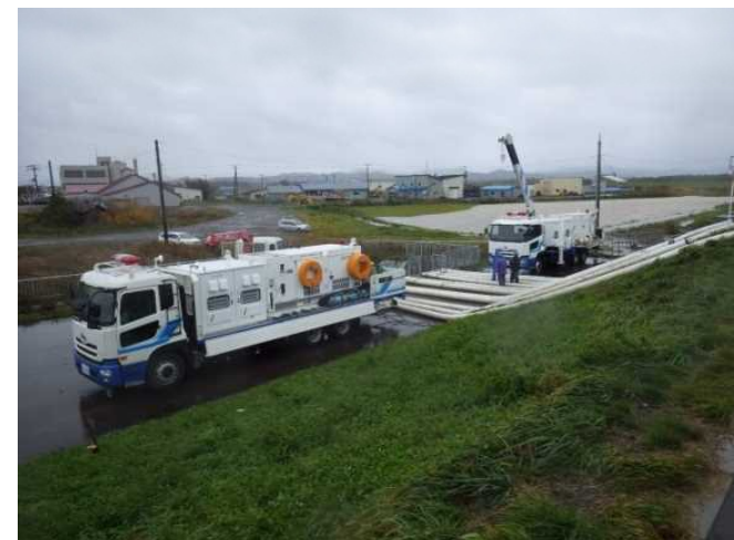
湧別川河口樋門釜場
