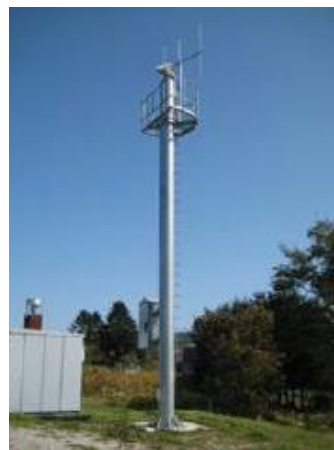
CCTVカメラの設置
