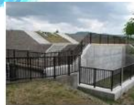
釜場の設置例
