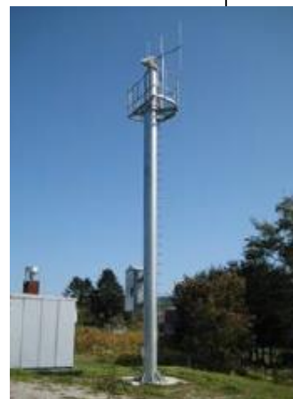
CCTVカメラの設置
