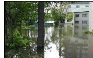
近年主要洪水 平成18年10月 （外水氾濫状況） 網走湖畔ホテル冠水
