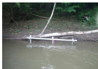
簡易水位計などの設置
