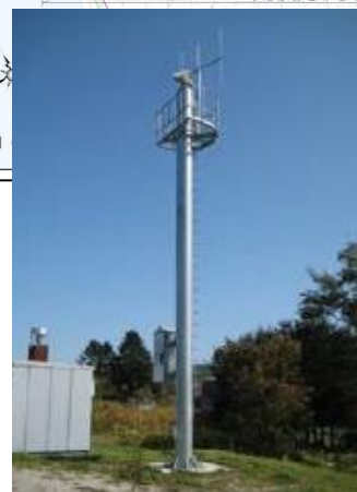
CCTVカメラの設置
