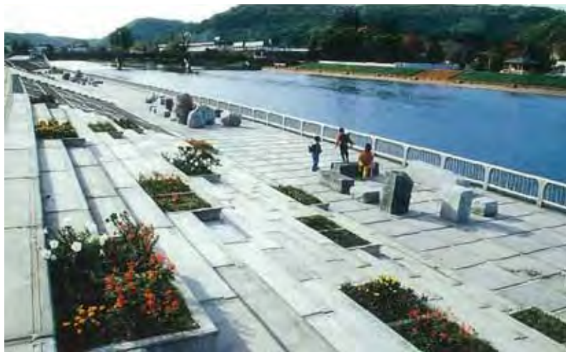
景観に考慮した護岸（下流部）
