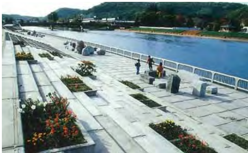
景観に考慮した護岸（下流部）
