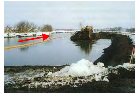
③ 下流域の河道掘削 (昭和62年～平成5年整備)
