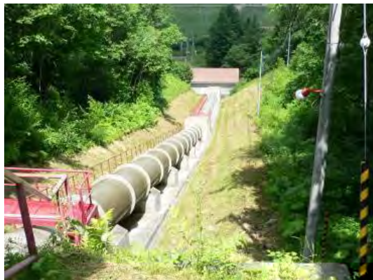
電力供給(700kw)を行う下津別発電所
