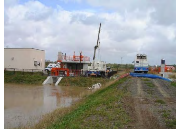
芭露川(2級河川) 排水ポンプ車による排水状況 (網走開発建設部より派遣)
