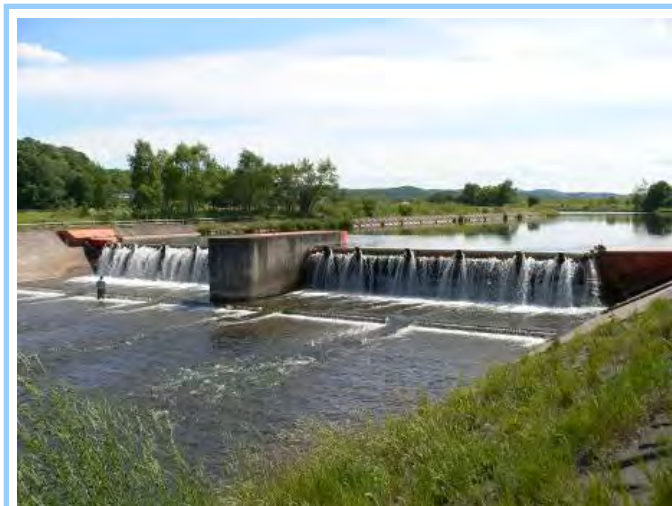
下流から見た西幹線頭首工
