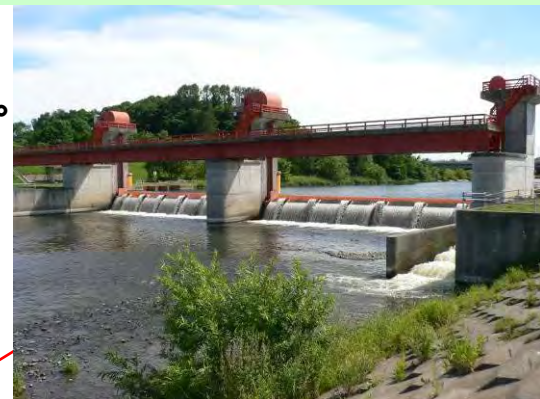
田畑に(600ha)かんがい用水を供給する東幹線頭首工
