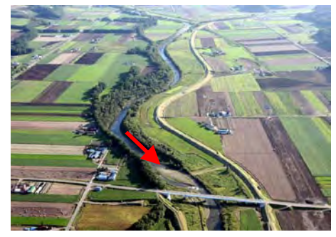
④ 中流域の堤防整備 (昭和54年～昭和55年整備) 平成19年撮影
