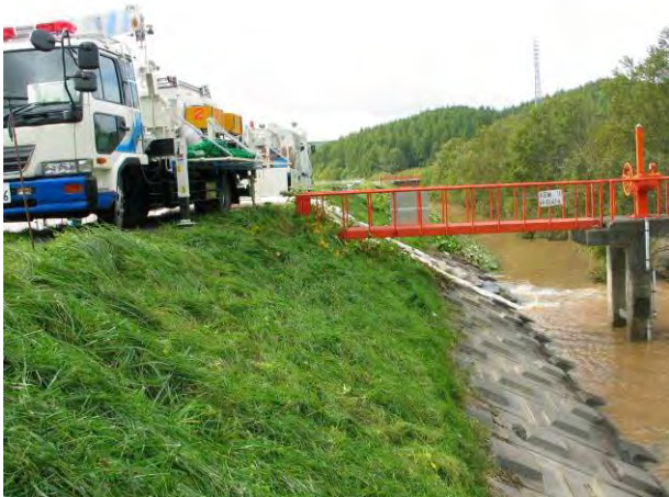
常呂川北見市 ポンクマ樋門 排水ポンプ車稼働状況 (十分な足場が確保出来ない中での排水作業)
