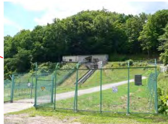
電力供給(300kw)を行う津別発電所
