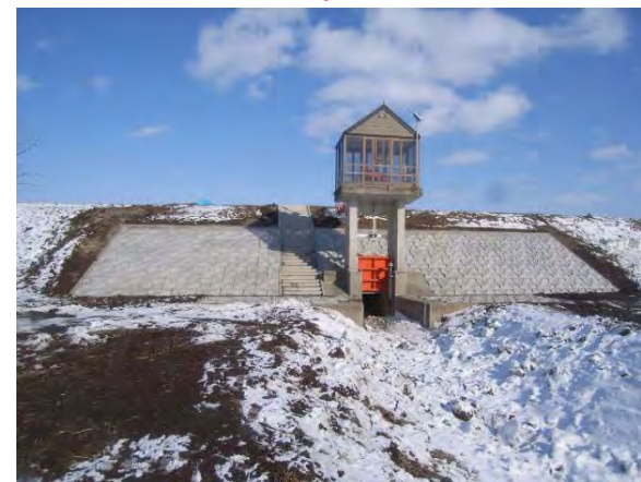
舟木樋門補修後(グラウト工)
