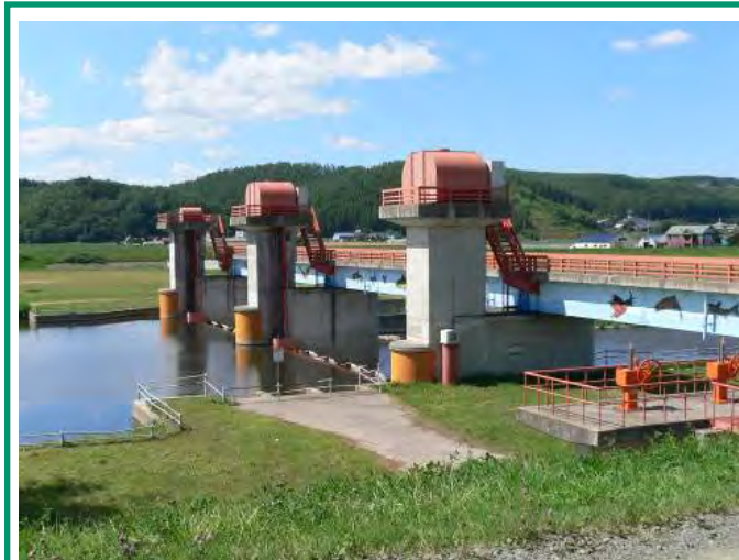
上流から見た東幹線頭首工
