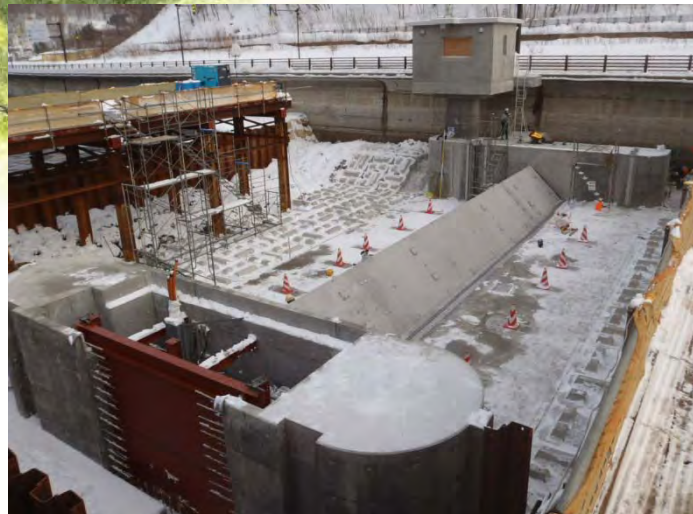
塩淡水境界層制御施設施工状況
