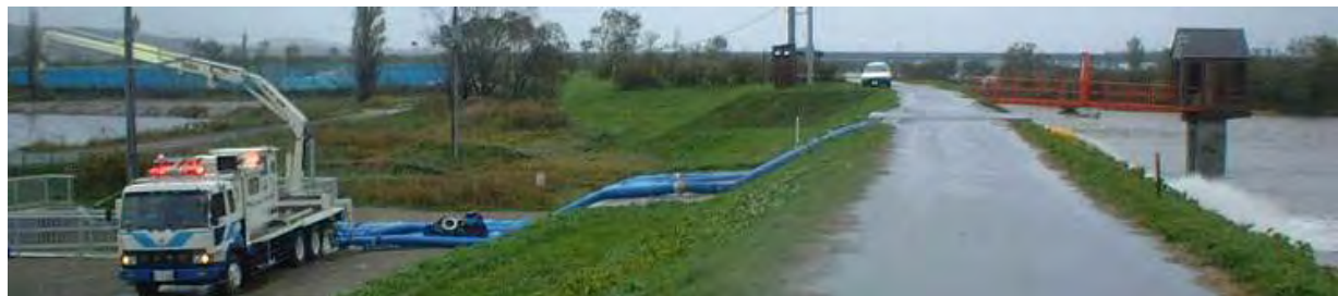
網走川水系美幌川日甜樋門排水ポンプ車稼働状況
