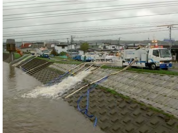
美幌川美幌町市街 稲美樋門 排水ポンプ車稼働状況 (作業場が狭い堤防上での排水作業)
