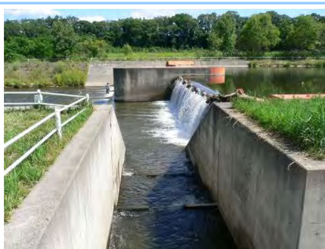
魚道の流下状況
