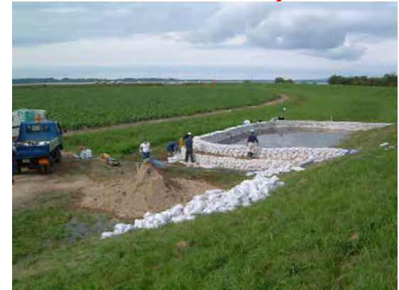
網走湖湖岸堤の漏水時の状況(住吉地区)
