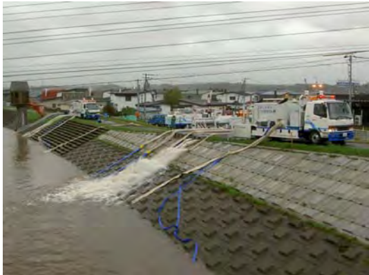
ポンプ車による水防活動
