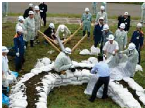
水災訓練の状況(月の輪工法)
