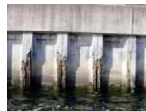
矢板護岸劣化状況
