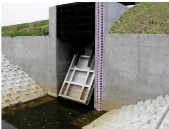
フラップゲート (自動的に開閉するゲート)
