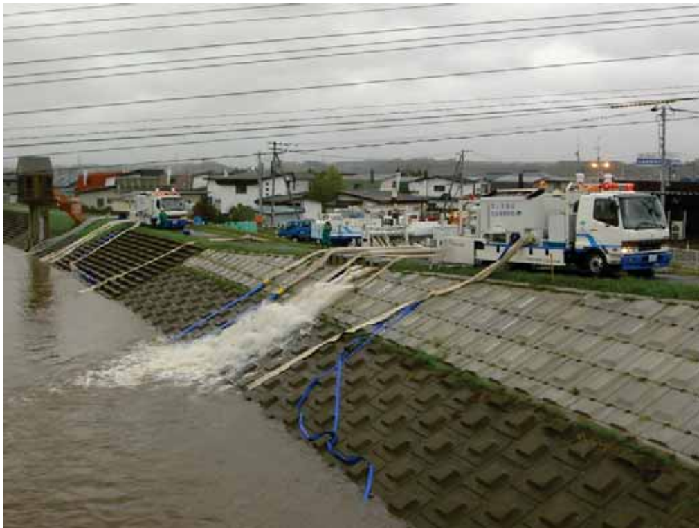
ポンプ車による内水排除の状況
