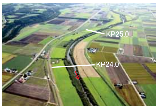
河道掘削(河積の確保対策)の実施区間
