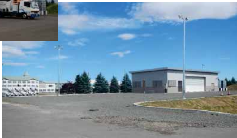
美幌地区水防拠点
