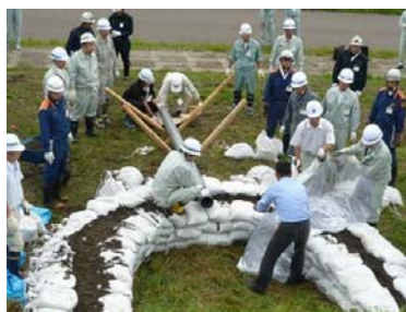
水防訓練の状況 (月の輪工法)
