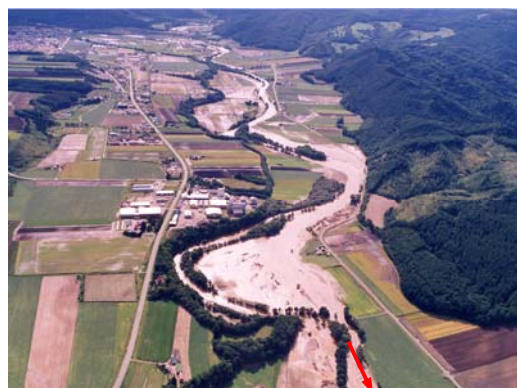
平成 4 年 9 月洪水の状況 いわとみ (津別町岩富地区)
