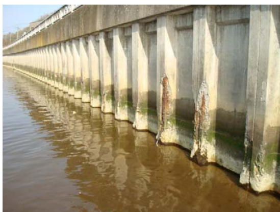
矢板護岸補修前
