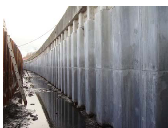
矢板護岸補修後
