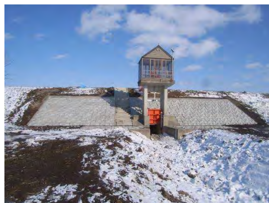
樋門周辺の護岸補修後 (機能の維持を目的とした補修)
