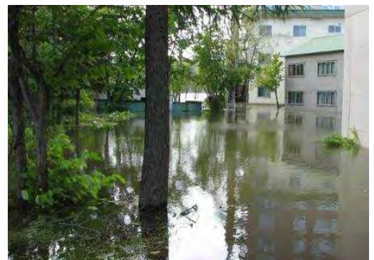
平成 18 年 10 月洪水の状況 (網走湖畔にある観光ホテルの浸水状況)
