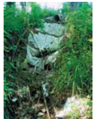
流末処理が行われず生じた斜面侵食
