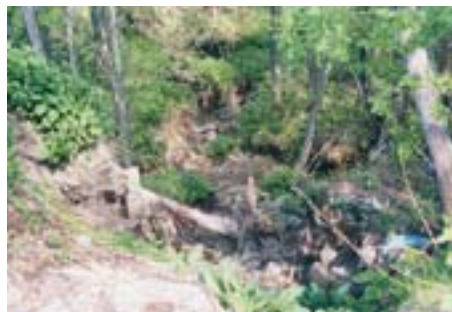
流末処理が行われず生じた斜面侵食
