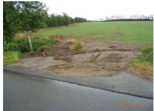
④畑地からの土砂流出状況
