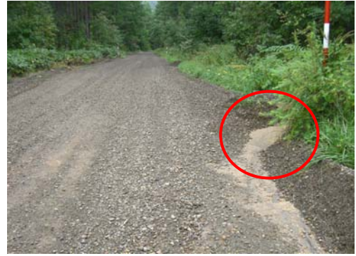
②砂利道路面のこまめな水切り実施による流出防止策
