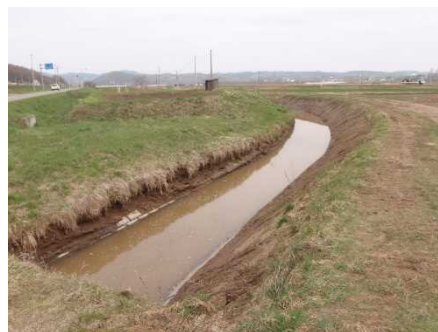
水路内の土砂上げ状況
