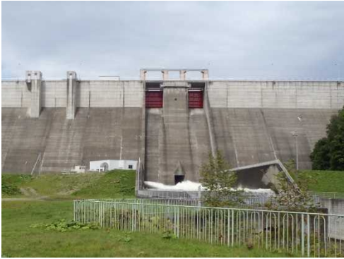
鹿ノ子ダムの堤体
