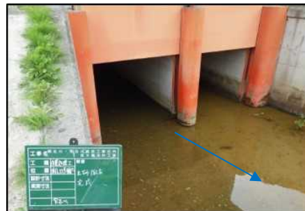
樋門吐口水路の土砂掘削状況
