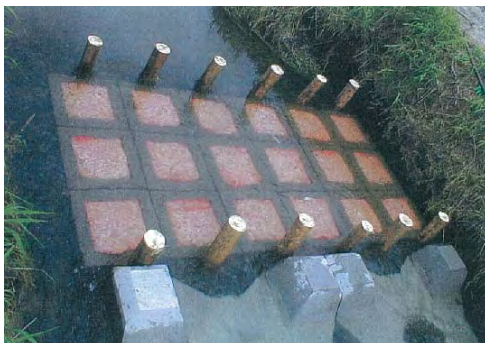
③ 浄化河床材敷設(貝殻)
